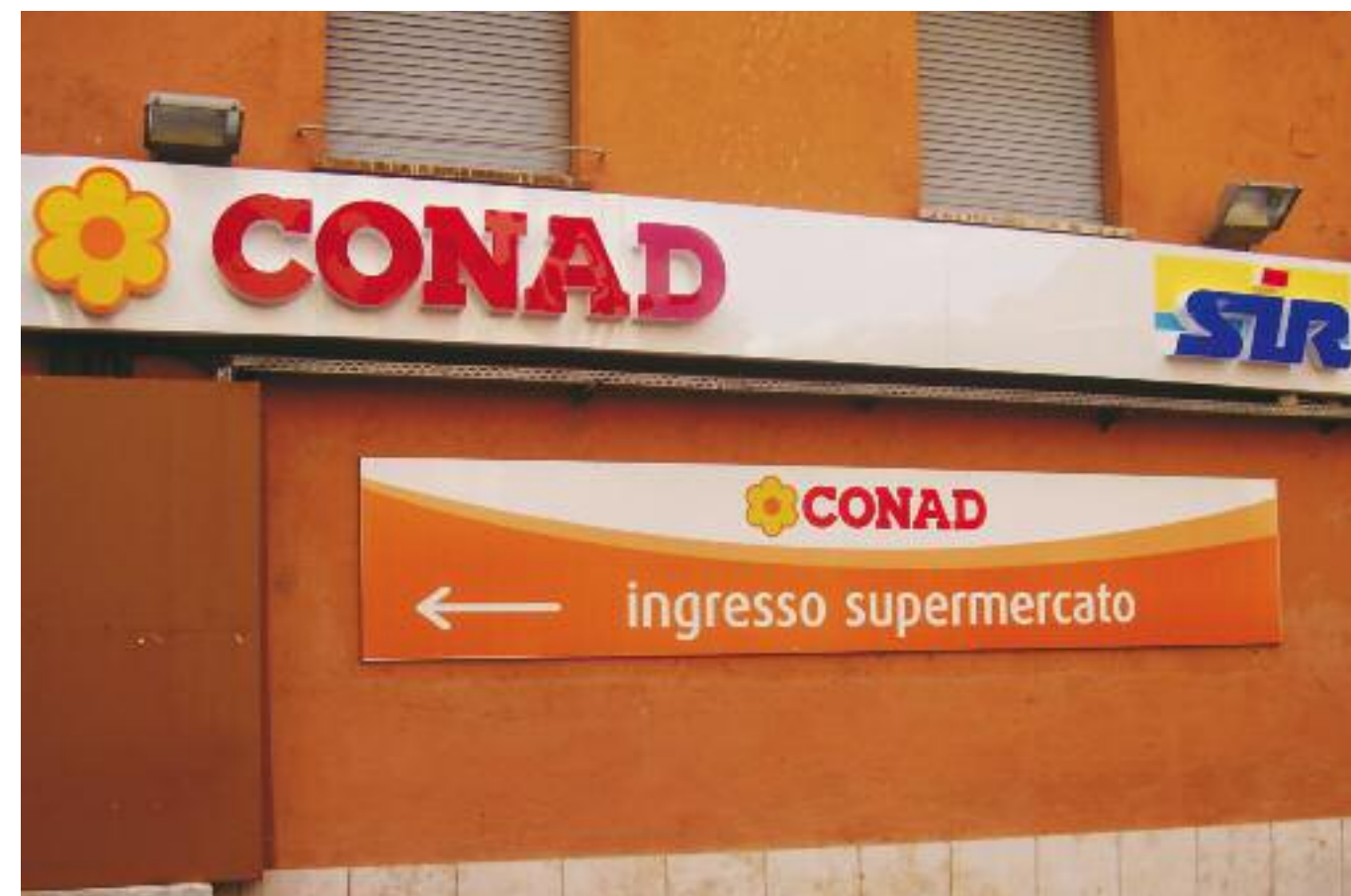
Insegne luminose a lettere scatolate in plexiglass fissate su fondo in metallo Plexiglass channel letters illuminated fixed on metal background
